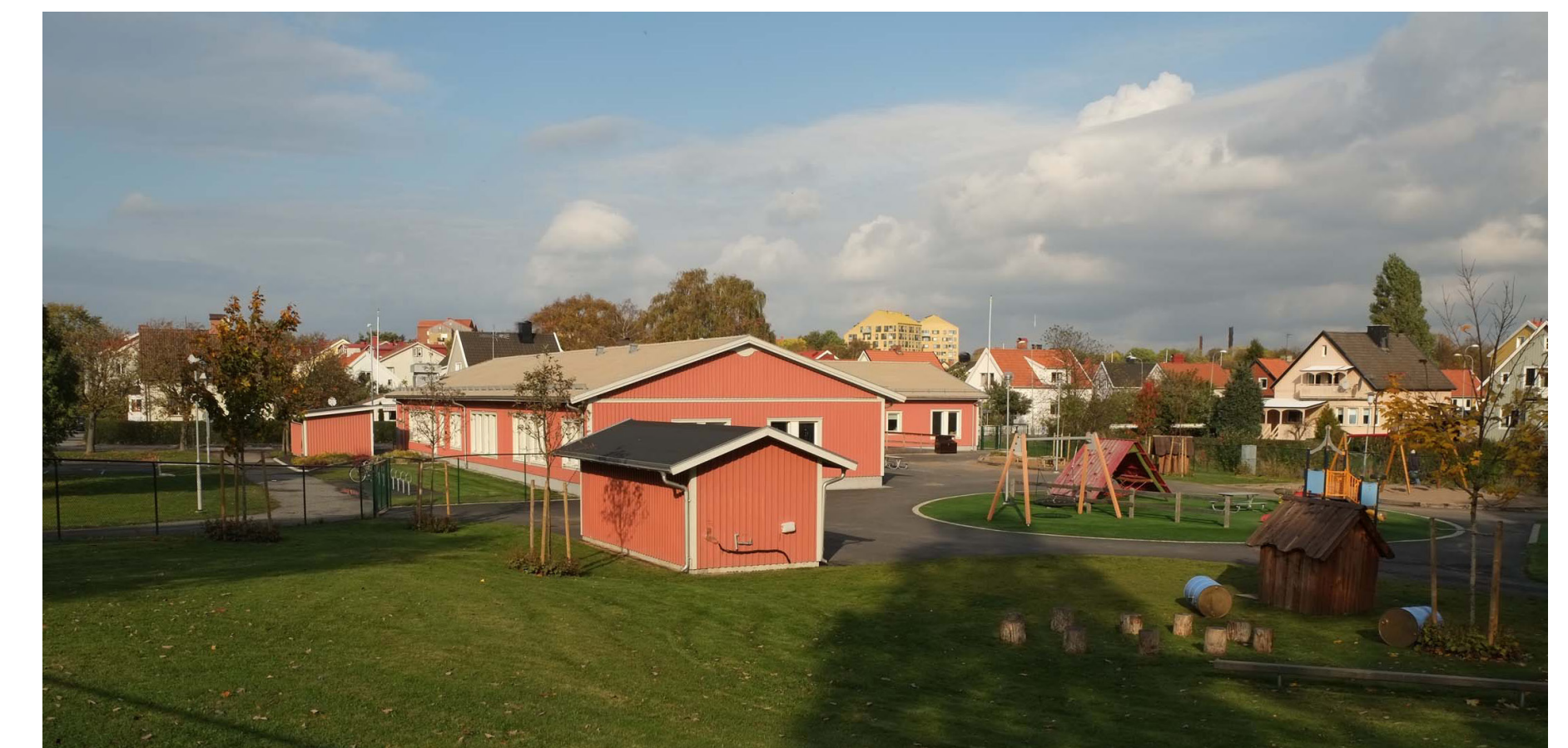
Befintlig tillfällig förskolebyggnad från söder.
